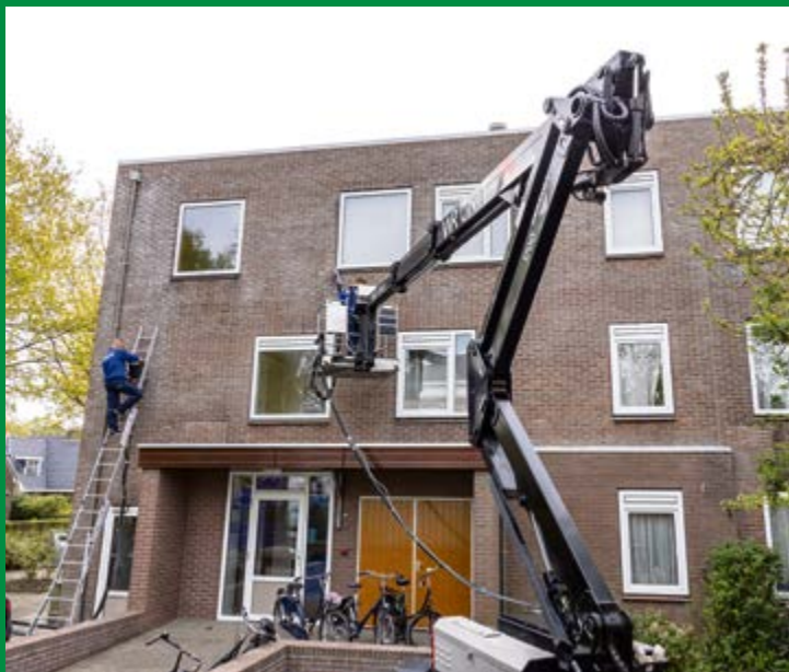
Bij een complex huurwoningen van WoonFriesland in Aldtsjerk heeft Koston Noord spouwmuurisolatie aangebracht met verlijmd HR++ Thermoparels.
